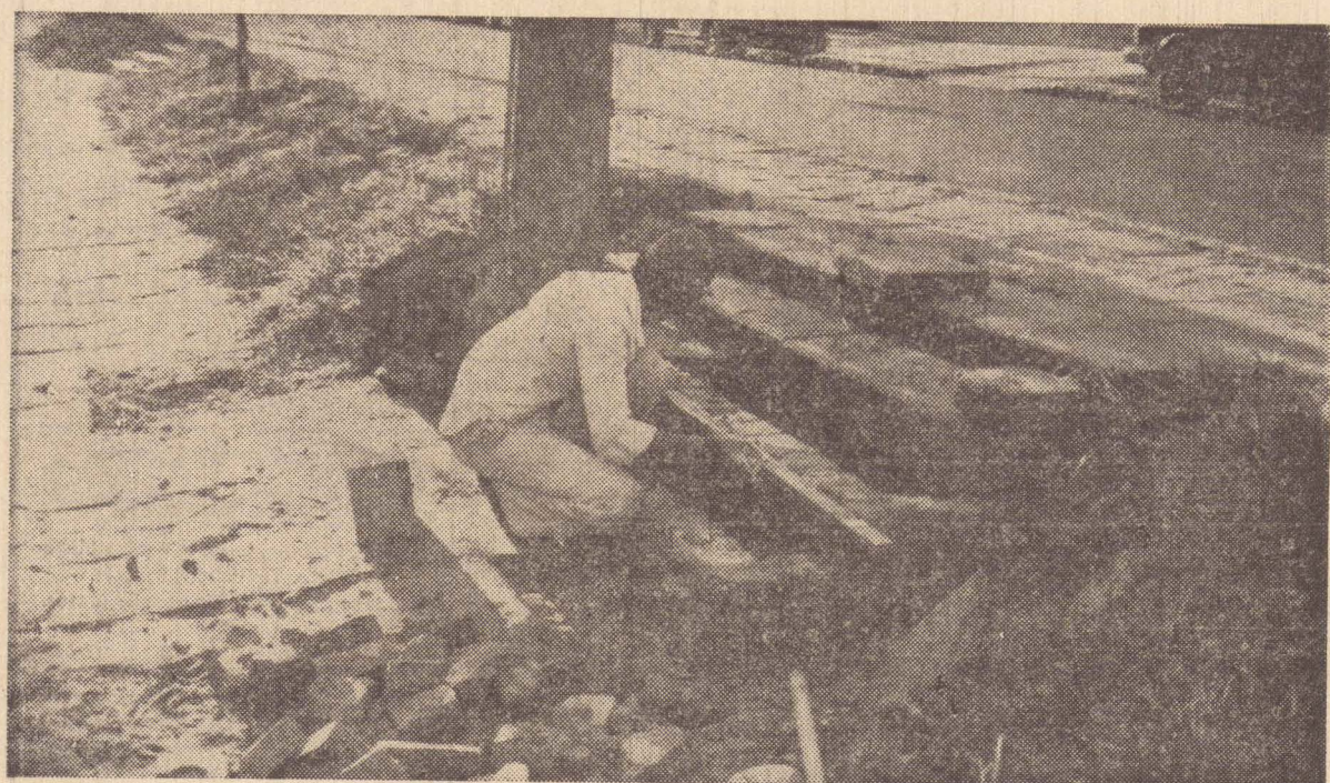
Os funcionários da LR Peretti estão reconstruindo o passeio e a escada do canteiro central
