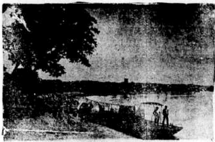
LORENA—REBOCADOR DAS BARCAÇAS DO ENCHENTE CENTRAL.
