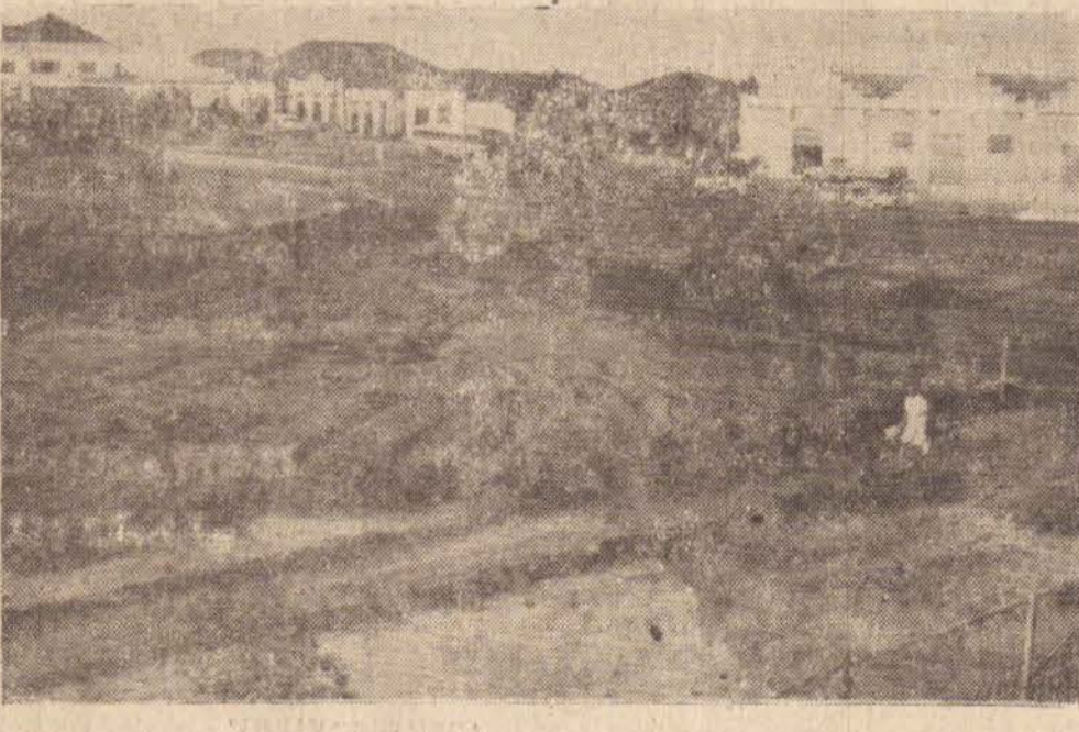
Outro ângulo — fotografado pela reportagem — dos trabalhos de adaptação do terreno onde se erguerá uma das mais suntuosas estações rodoviárias do Interior de São Paulo. Vê-se parte da ex-praça dos Pioneiros já inteiramente desfeita.
