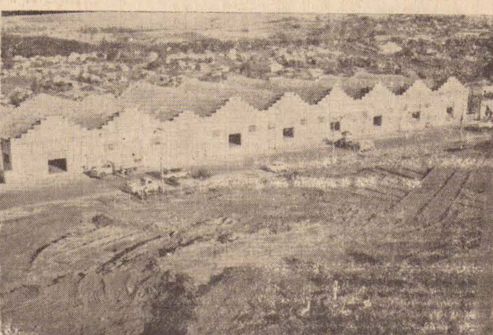
De cima da Caixa-d'água, Pedro Komat su fotografou os trabalhos que ilustram esta reportagem, e que servem de documento a uma das mais importantes iniciativas já tomadas em Presidente Prudente, marco inicial da edificação de uma das mais modernas e funcionais estações rodoviárias de São Paulo.
