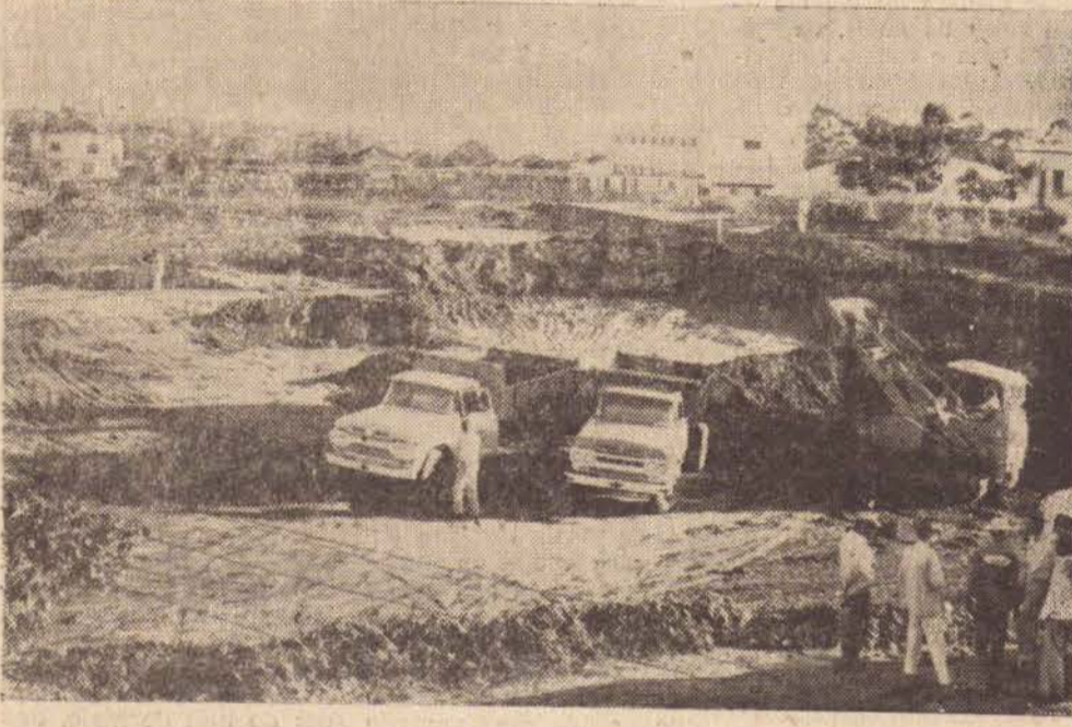
Processo de envolvimento e remoção de terra fotografado pela reportagem, do local onde se erguerá a Estação Rodoviária. O trabalho vem se desenvolvendo com rapidez, dada a presença de inúmeras viaturas postas em serviço.
