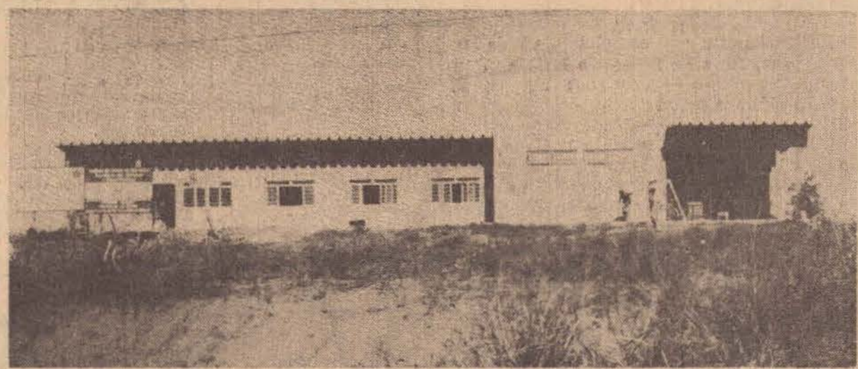
O Centro de Triagem já em fase final
