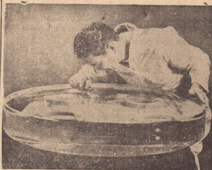
ESPELHO PARA MÁQUINA SOLAR — Um técnico examina a superfície de um espelho de 91,44 cm para uma câmara de televisão a ser levada a elevadas altitudes por balões não tripulados para fotografar e televisar o sol e outros corpos celestes. Chamado de Stratoscope II, o projeto é patrocinado pela Fundação Nacional de Ciências e pelo escritório de pesquisas da Marinha dos Estados Unidos. O espelho, fabricado pela Corning Glass de Nova York, pesa 184 quilos e tem 12,7 cm de espessura. A capacidade de carga do instrumento telescópico é de 1.814 quilos. Na série de provas Stratoscope I, em 1959, uma câmara telescópica de 30 cm foi enviada a alturas superiores a 24 quilômetros. Uma tripulação de cientistas, liderados pelo Dr. Martin Schwarzschild da Universidade Princeton, seguiu os vãos e orientou as transmissões de televisão em circuitos fechados. A câmara foi dirigida por controle remoto da terra. Em dois vãos preliminares, em 1957, não foi usado o sistema de focalização de controle remoto.
