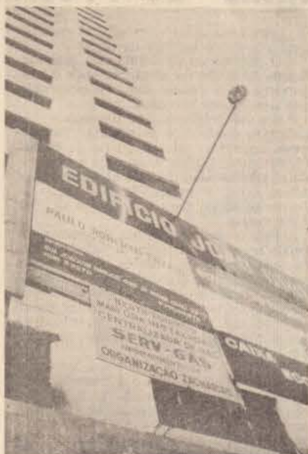
Edifício João Giglio, à Av. Washington Luiz, já em fase de acabamento, pioneiro em gás canalizado na região da Alta Sorocabana.
