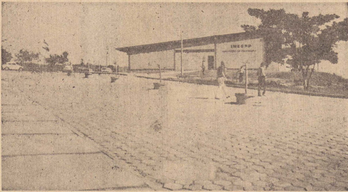
No pátio, foi implantado calçamento de bloquete.
