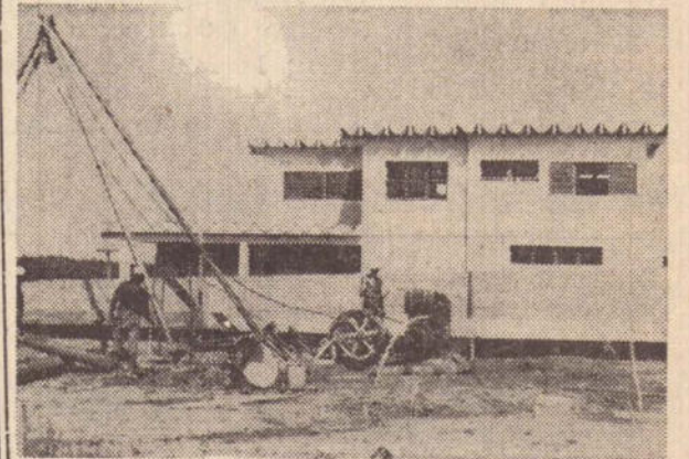
As obras da nova igreja já estão em andamento.
