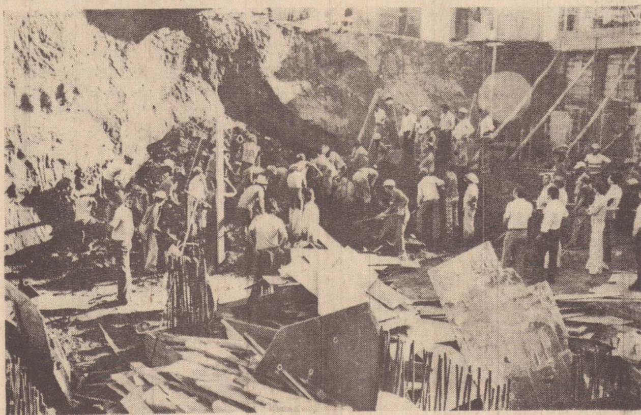
No canteiro de obras a desesperada procura de prováveis colegas sob a montanha de terra.
