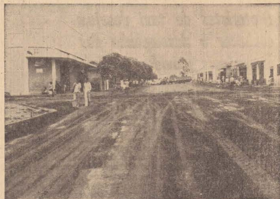
O asfaltamento numa das largas avenidas de Ivinhema.
