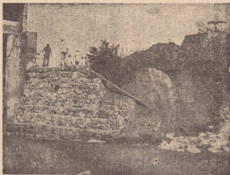
Na ponte do Rio do Peixe, a Prefeitura teve que fazer a cabeceira com enrocamento de pedra e gabiões, usando 600 m3 de pedra amarrada.
