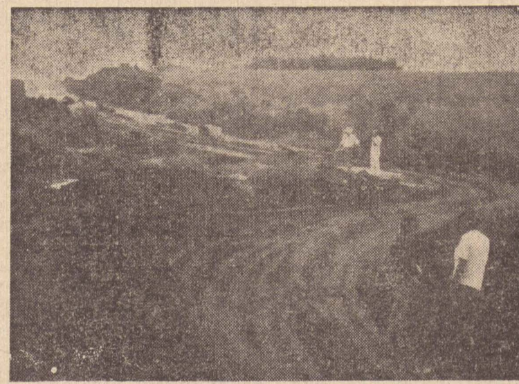
Na estrada do Mirante, mais uma obra que exigiu muitos recursos da Prefeitura, na recuperação do leito
