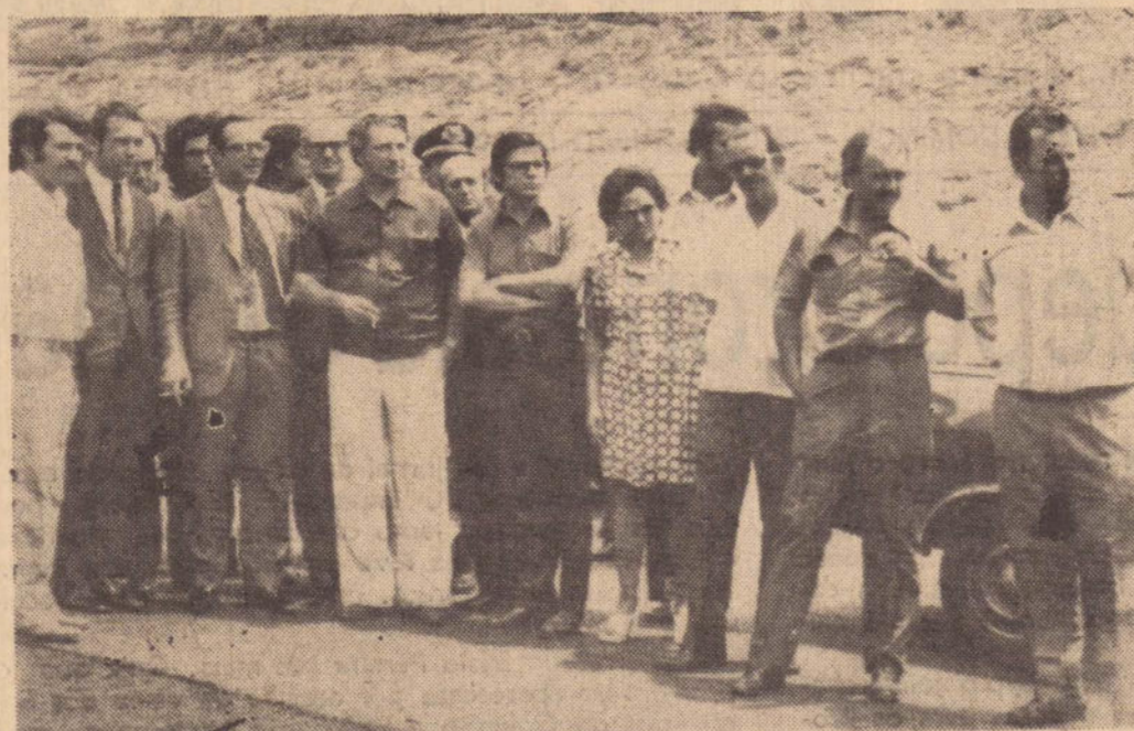
Engenheiros do DER, prefeitos e outras autoridades acompanham os trabalhos de inspeção de um importante trecho da SP-425, em execução próximo a Pres. Prudente
