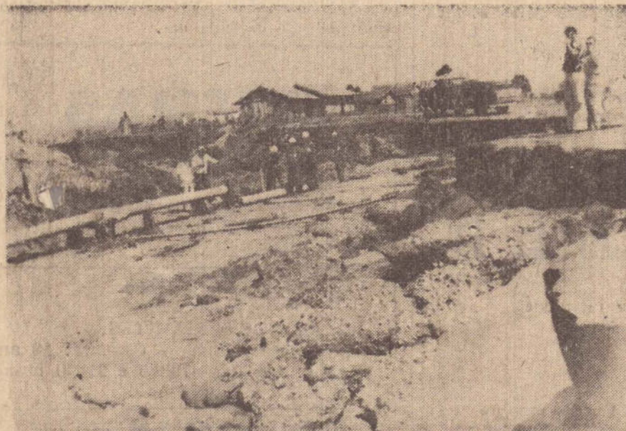
Equipe da SABESP fazendo estaqueamento na rede d'água para o bairro da Estação na confluência das Avenidas, Pernambuco e Pirapozinho.
