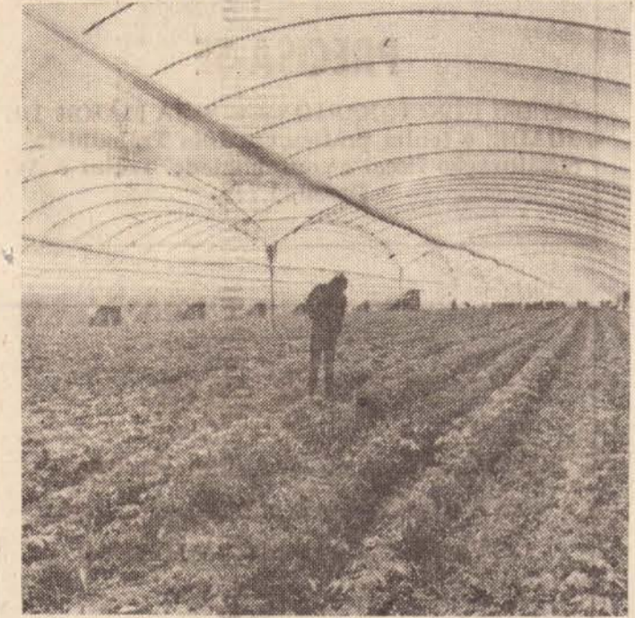
FOTO A — Esta estufa gigante, de plástico, em Wooster, Ohio, EUA, a maior estrutura inflada do mundo, em sua espécie, pode ser a precursora de estruturas infláveis, capazes de cobrir comunidades inteiras. O conceito de construção, desenvolvido pela Goodyear Tire & Rubber Company, dos EUA, torna-a excepcionalmente econômica, para cobrir grandes áreas com edifícios, árvores e outros objetos.
