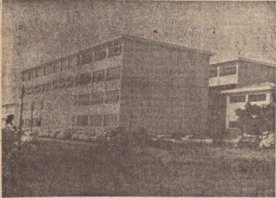
Detalhe do moderno edifício que abriga a Faculdade de Odontologia de Presidente Prudente
