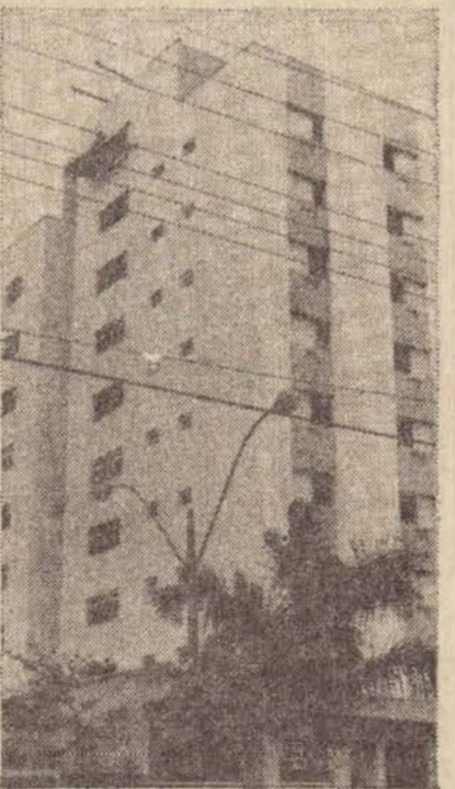
Edifício "Sergio Lopes da Silva" Av. Washington Luiz, 142 10 pavimentos 16 apartamentos 16 boxes-garagem área construída: 3.610,20 metros quadrados (empreendimento em obras) unidades à venda previsão de entrega: 1980
