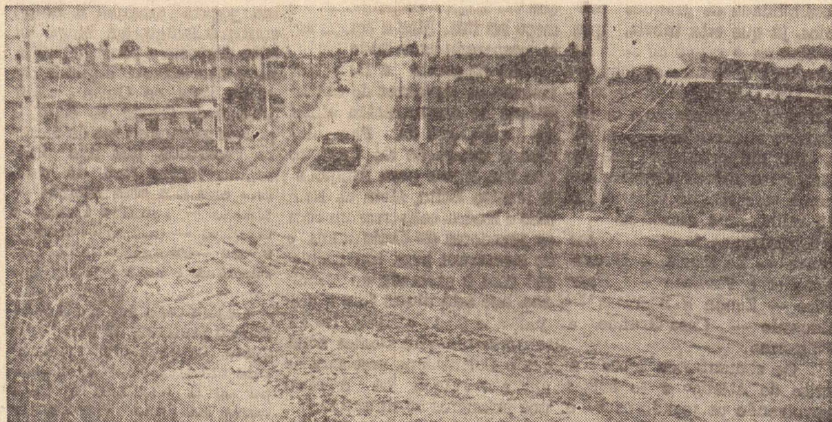
Caminhões enfrentam dificuldades para ter acesso à Indústria J.B. Duarte em Santo Anastácio pela rua 15 de Novembro. A indústria pede a pavimentação da via pública.
