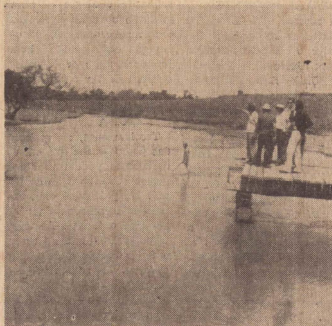
Denari Jr. mostra o assoreamento que atingiu o Córrego Santo Antonio e o Rio Guaruaia. A nova ponte está ainda em construção, no local.
