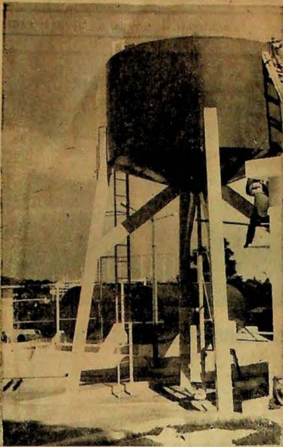
Caixa de água para trinta mil litros, abastecendo assim todo o hospital. Foi feita numa indústria prudentina.
