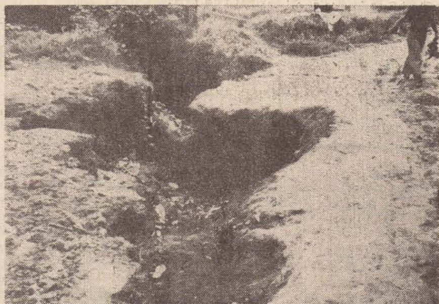
A cratera cresce, tomando conta de toda a rua Vereador Pedro Tofano, impedindo o trânsito de veículos.
