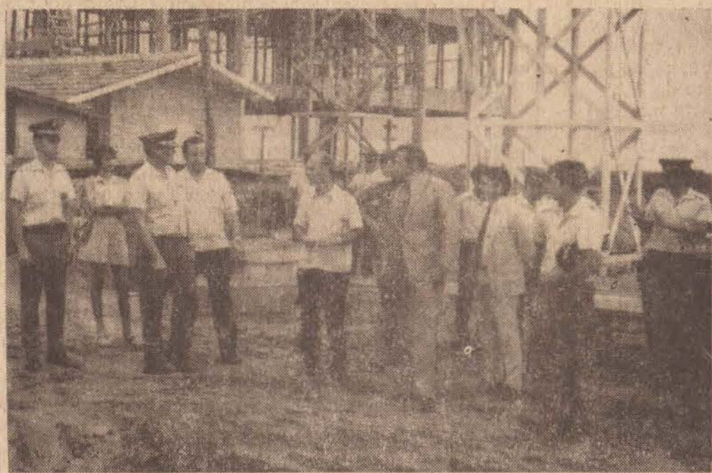
O Major Sergio Ostini, ao lado de representantes da imprensa e da oficialidade percorre o canteiro de obras da Unidade Integrada.
