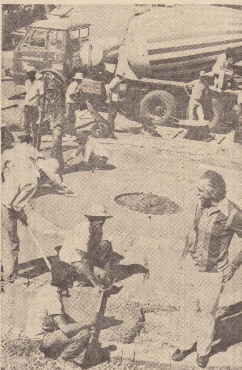
O prof. Benedito A. P. do Lago visitou as obras de implantação do paisagismo no primeiro bloco do Parque do Povo, entre as Avenidas Brasil e Cel. Marcondes.
