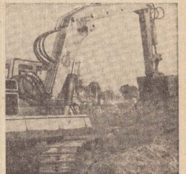
... não terá mais esse problema com as obras iniciadas pela prefeitura.
