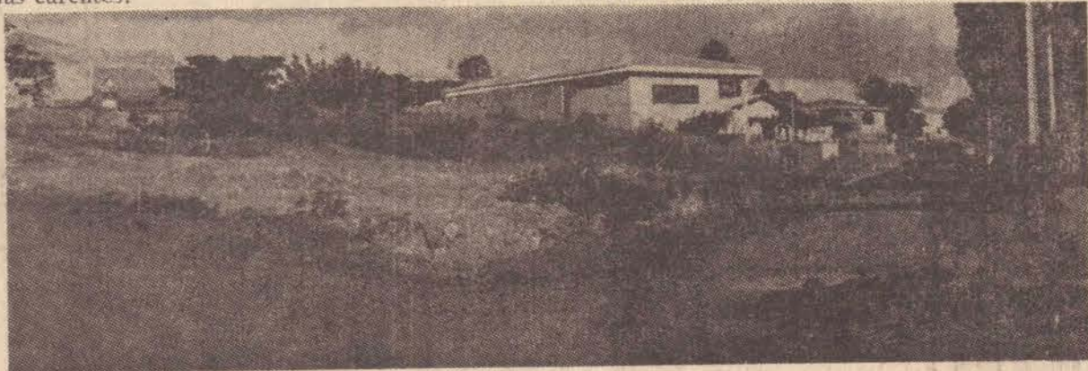
A Prudente vai iniciar a pavimentação da pista norte e as ligações com varias ruas.
