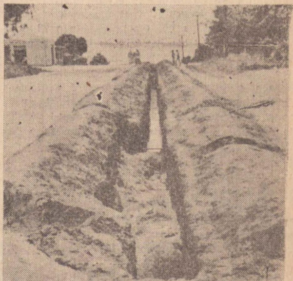
Há dois meses a prefeitura abriu esta valeta para encanar a rede de esgoto,
