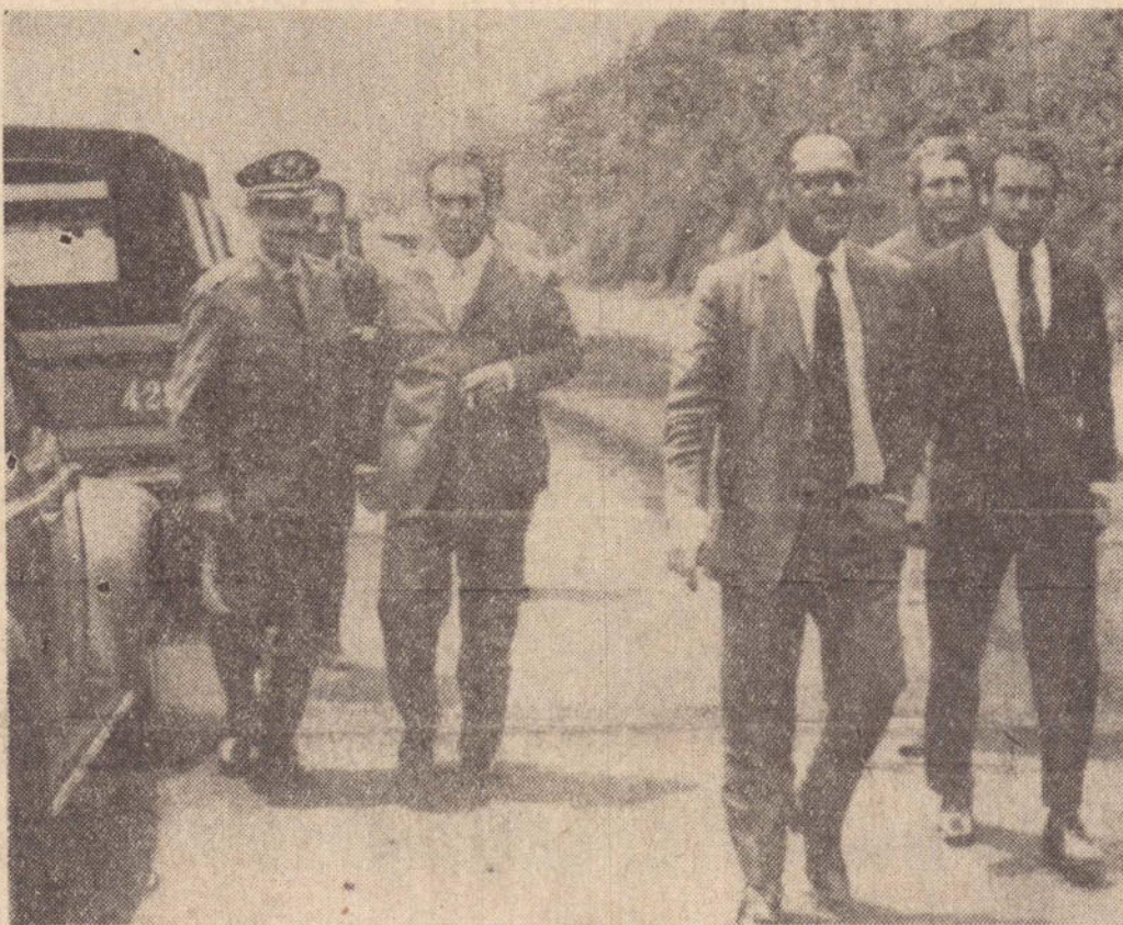
Obras da SP-425 entre Pres. Prudente e Martinópolis foram inspecionadas pelo Secretário dos Transportes.
