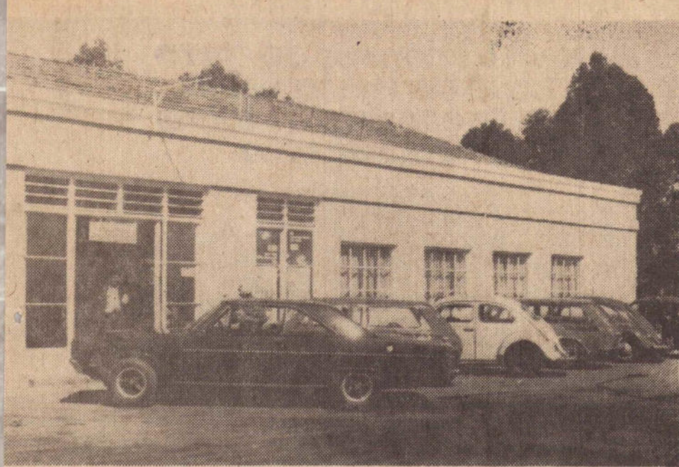
Esta é a nova fachada que o Posto e Restaurante Presidente receberam após a ampla remodelação porque passou.
