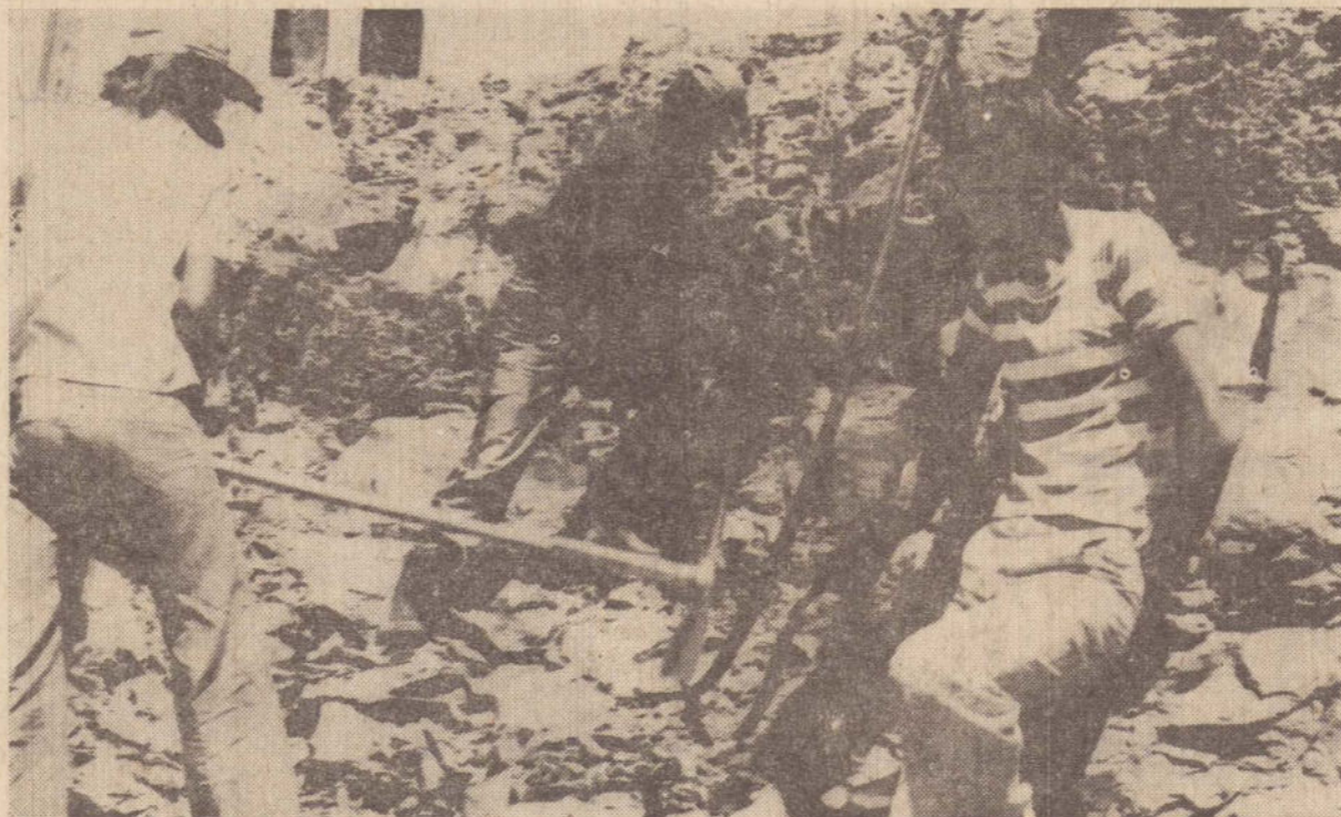
O operário britador, Rosalvo Miguel dos Santos foi o autor do achado, numa pedreira junto a Subestação da Caiuá.
