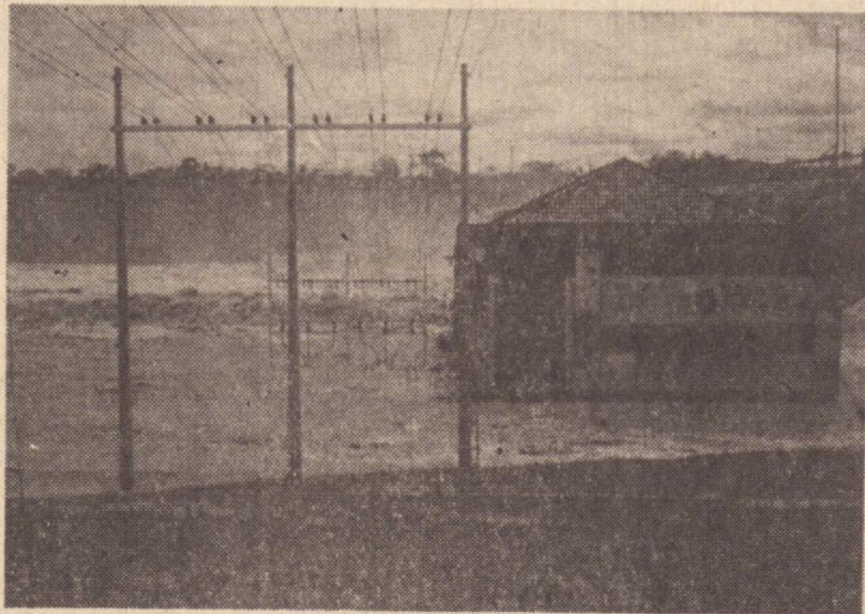
Nesta fotografia o destaque da casa das máquinas parcialmente submersa. As águas cobriram a porta do edifício e danificaram no seu interior o equipamento elétrico e máquinas.
