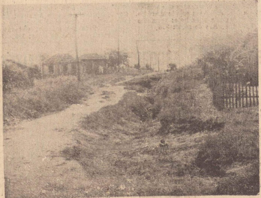
A foto mostra o estado em que se encontra a rua.
