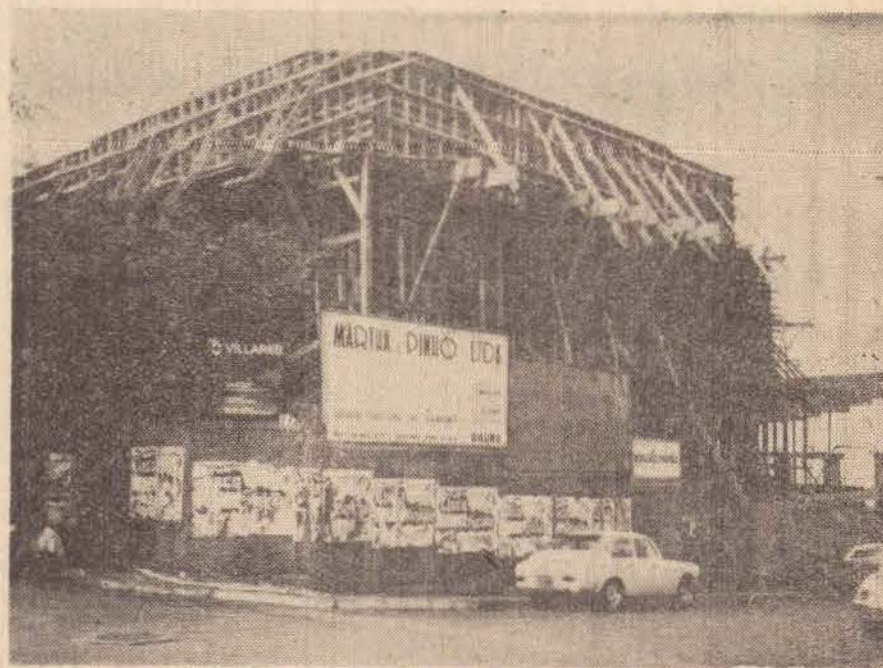
Em obras aceleradas o prédio da Telesp
