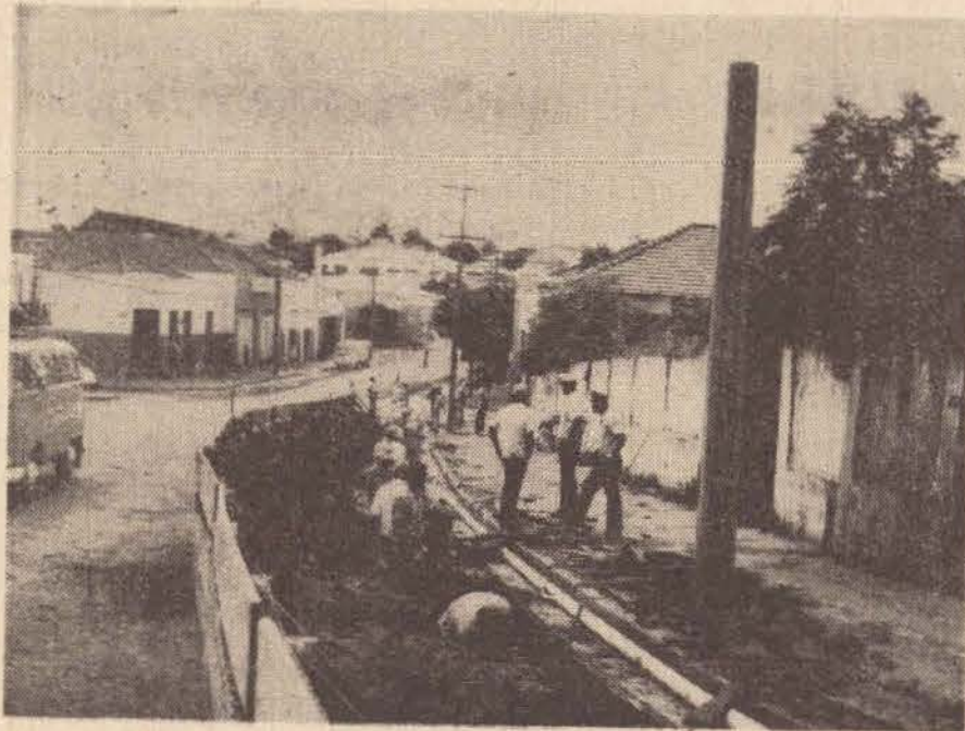
Os cabos já estão sendo estendidos
