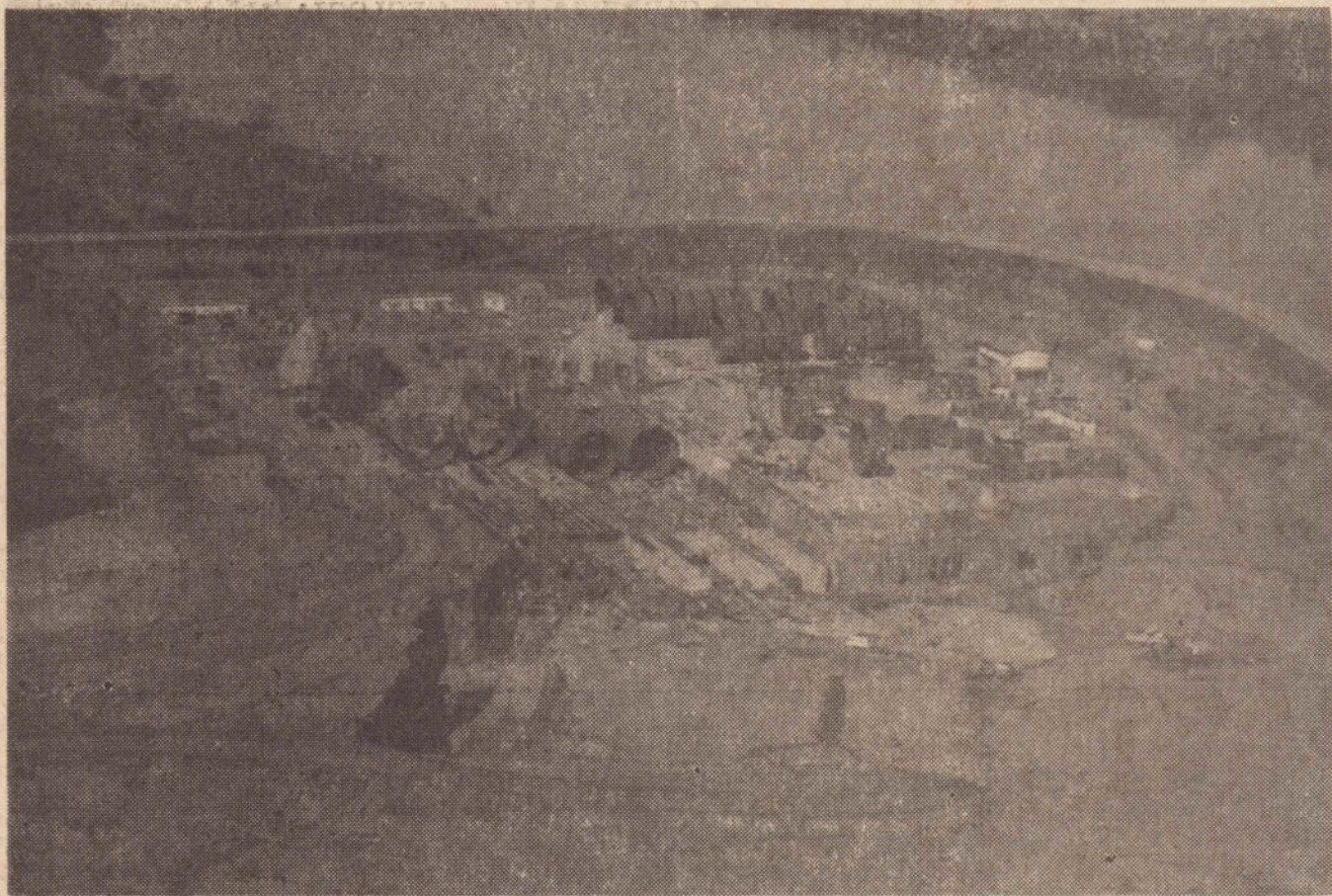
As obras da Usina Hidrelétrica de Capivara, se desenvolvem em ritmo acelerado e não sofrerão atraso.
