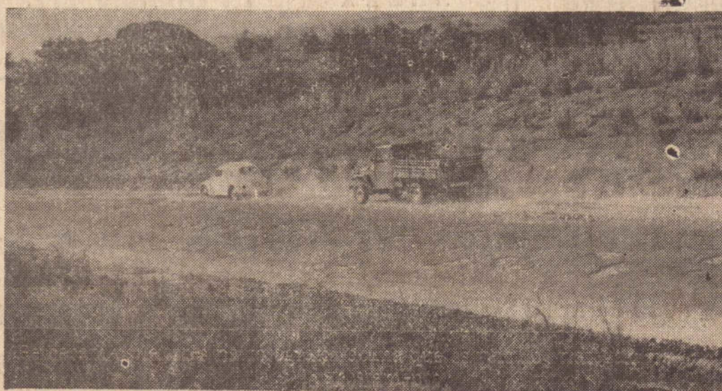
Percebam os leitores na fotografia acima que os veículos trafegam pelo acostamento.
