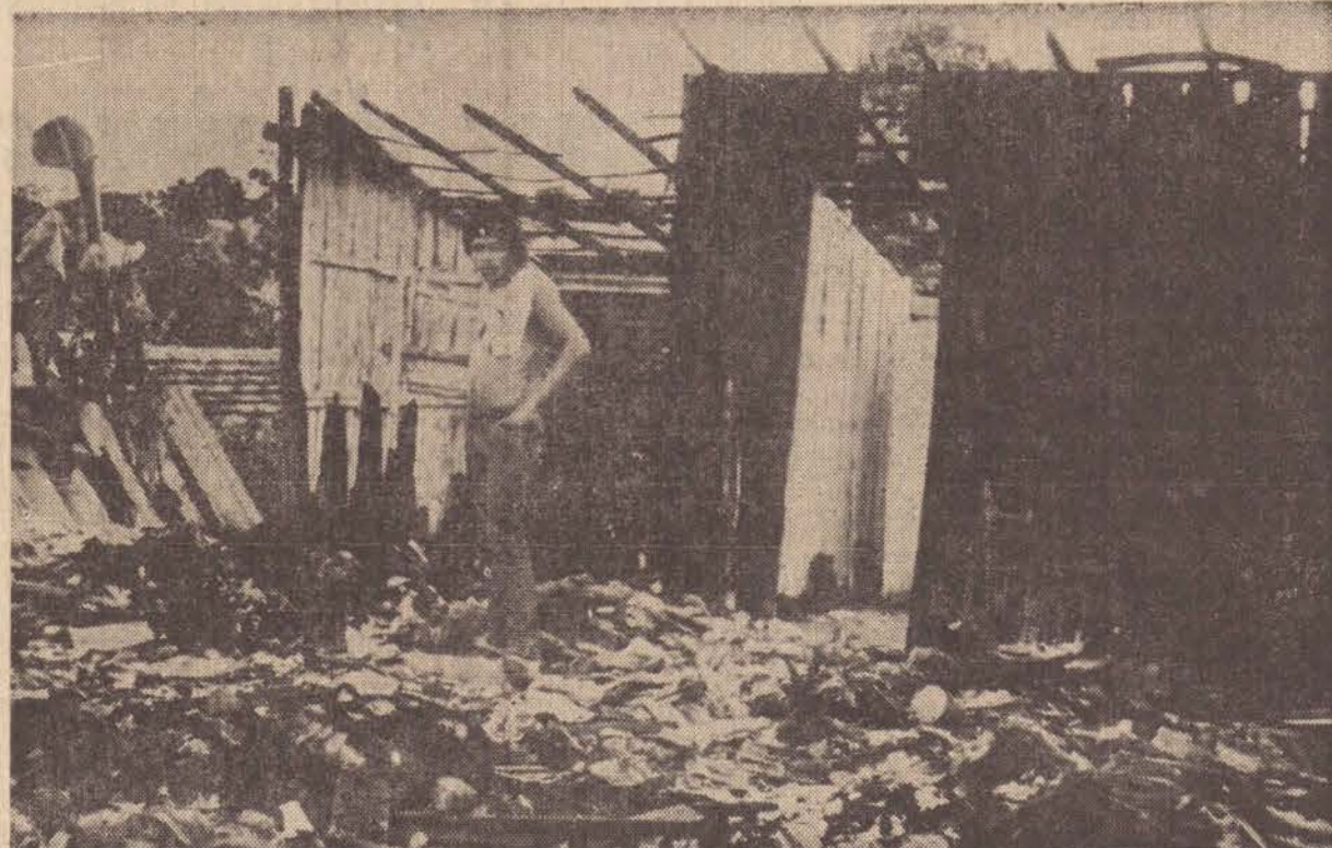
A casa de Zacarias Antonio da Silva ficou totalmente destruída
