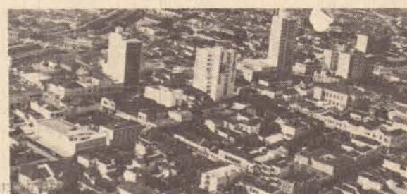
As obras da via expressa que ligará o Centro de Marília a um núcleo habitacional estão paradas porque, segundo o prefeito da cidade, a Secretaria do Planejamento do Governo Estadual está retendo a verba prometida.
