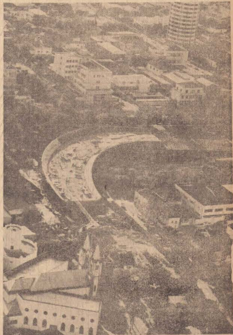
Uma vista-aérea do viaduto na fase de construção e agora praticamente concluído.
