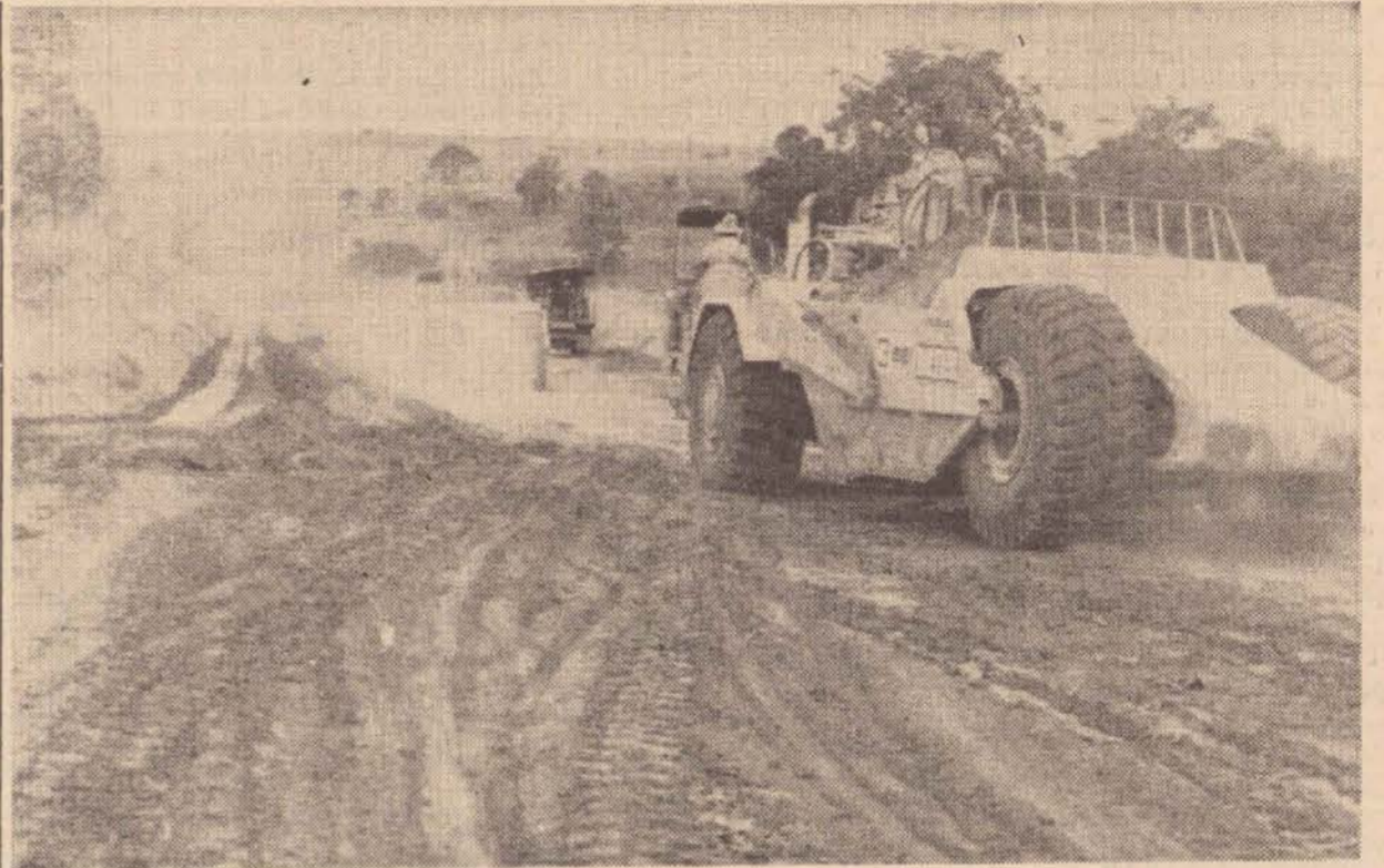
As moto-scrapers abrem caminho, nas proximidades do Córrego Limoeiro, no primeiro estágio do "Contorno Rodoviário", que terá 18 meses de prazo para conclusão.
