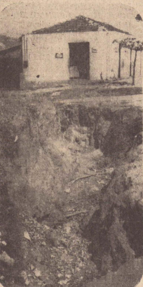
O proprietario ao lado faz "malabarismo": se abusar, cai com o carro no buraco. Ou derruba a parede do seu emporio.
