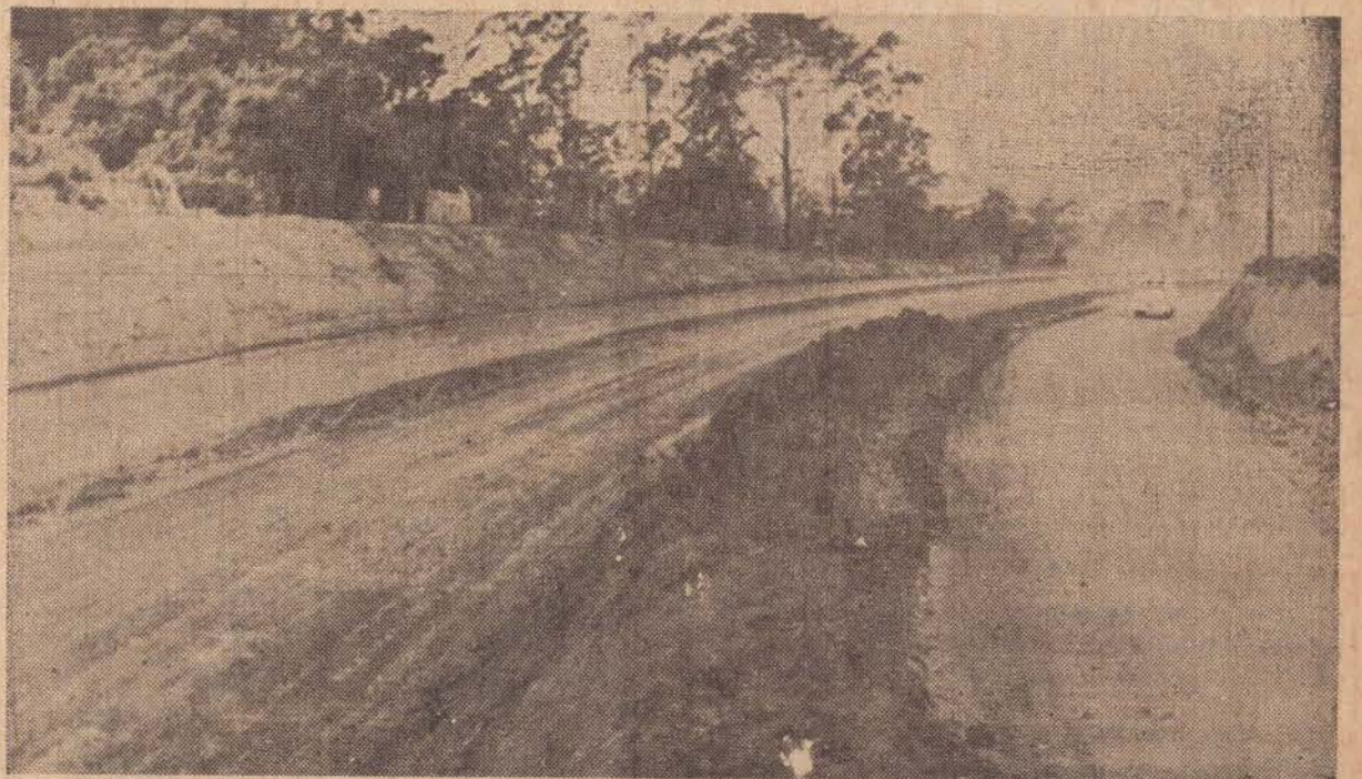
Entre a Av. Manoel Goulart e a perimetral do Prudentão, está tudo pronto para a pavimentação do novo traçado da estrada.
