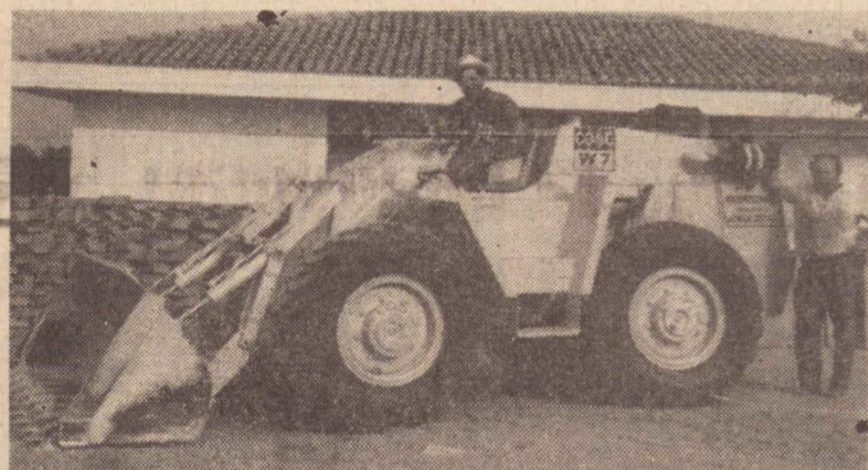
Pá-carregadeira, já em funcionamento.
