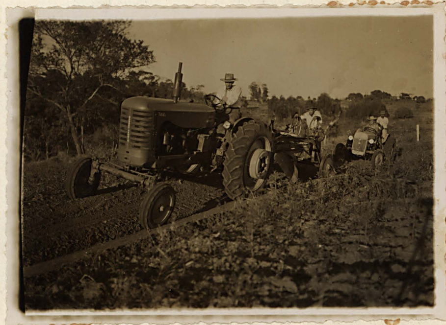
Execução de um terraço com a lamina. Foto - 1-954
