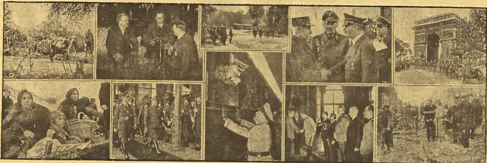
Ereignisse des Kriegsjahres 1940. — Oben von links: Italienische Truppen im griechischen Kalamagebiet. Auf schnell errichteten Uebergängen drangen die italienischen Truppen im Epiros vor. — Der sowjetrussische Aussenkommissar Molotow besuchte die Reichshauptstadt und wurde vom Führer in der Neuen Reichskanzlei empfangen. — Compiègne 1940: der deutschen Truppen ziehen in Paris ein. Vorbeimarsch vor der Generalität auf dem Place de l'Etoile. — Unten von links: Volksdeutsche aus Wolhynien kehren in ihre deutsche Heimat zurück. — Die Begegnung des Führers mit dem spanischen Staatschef Generalissimus Franco an der spanisch-französischen Grenze. — Der Führer und der Duce verabschieden sich nach ihrer Zusammenkunft auf dem Brenner. — Nach dem Beitritt Ungarns zum Dreimächtepakt begrüsst der Führer die Staatsmänner in dem berühmten Schloss Belvedere in Wien. — Die deutsche Luftwaffe übte tausendfache Vergeltung: Das englische Königspaar besichtigt eine Trümmerstätte in London.
