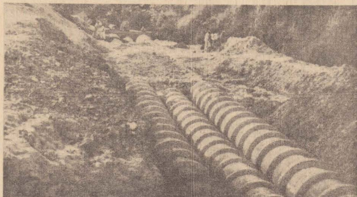
Hoje essa tubulação já não é mais vista porque centenas de caminhões de terra já o estão cobrindo.
