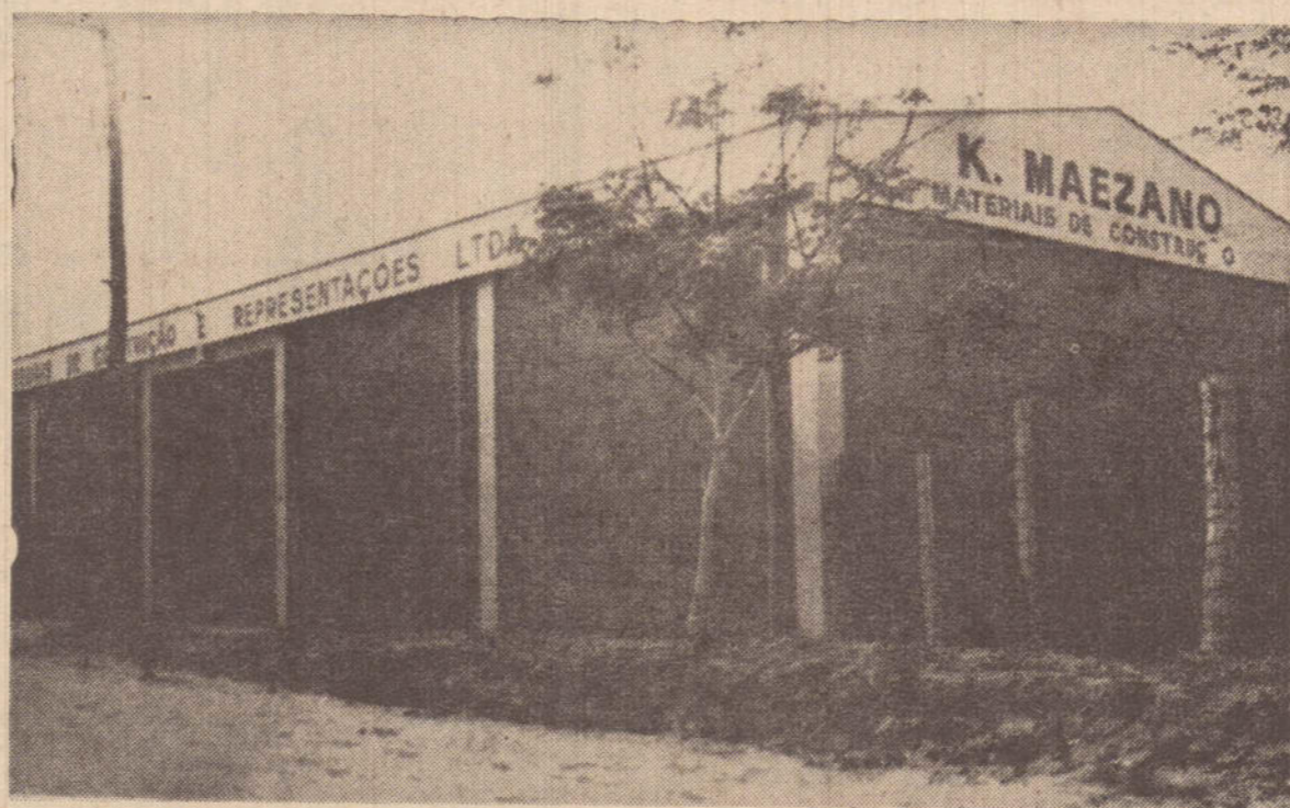
Vista do espaçoso depósito de K. Maezano — Materiais de Construção e Representações Ltda., mais uma empresa do Grupo Dr. Kazuo Maezano.
