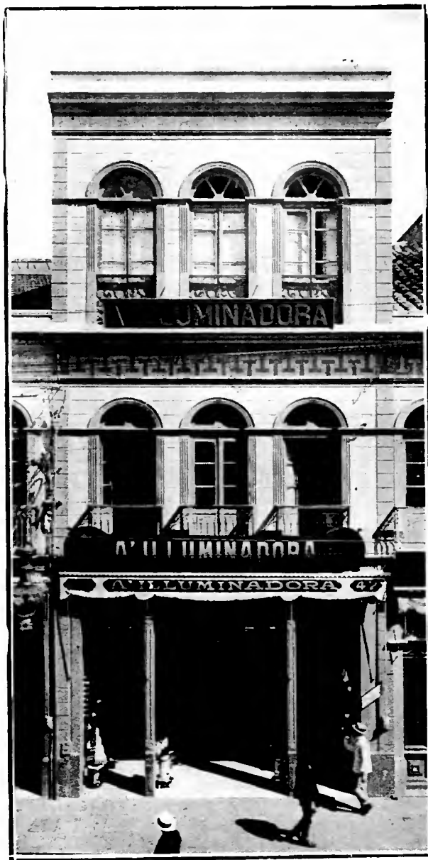
Fachada do prédio onde funciona A' ILLUMINADORA, à rua da Boa Vista n. 47 - S. Paulo
