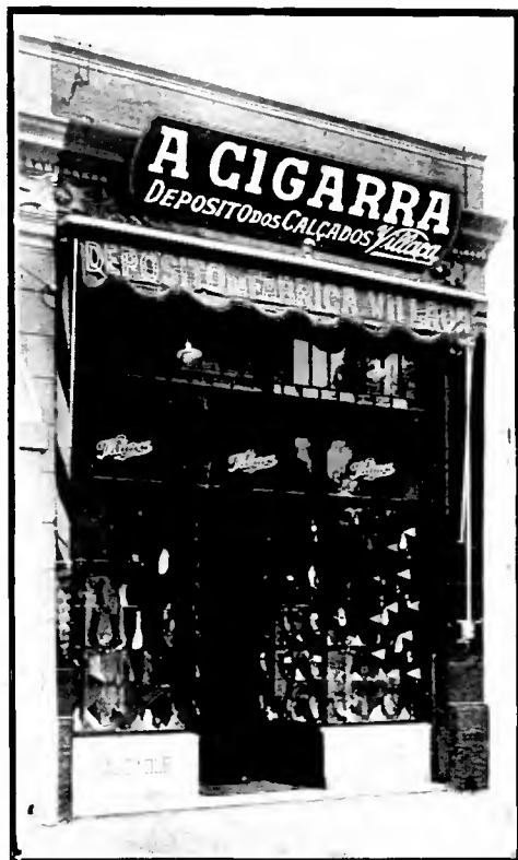
Fachada do importante estabelecimento de calçados Vil- laça, denominado "A Cigarra" em homenagem à nossa revista, e que foi recentemente inaugurado nesta capi- tal, à rua Sebastião Pereira n. 12, onde o publico en- contra excellente e variado sortimento, confeccionado com capricho e solidez.
