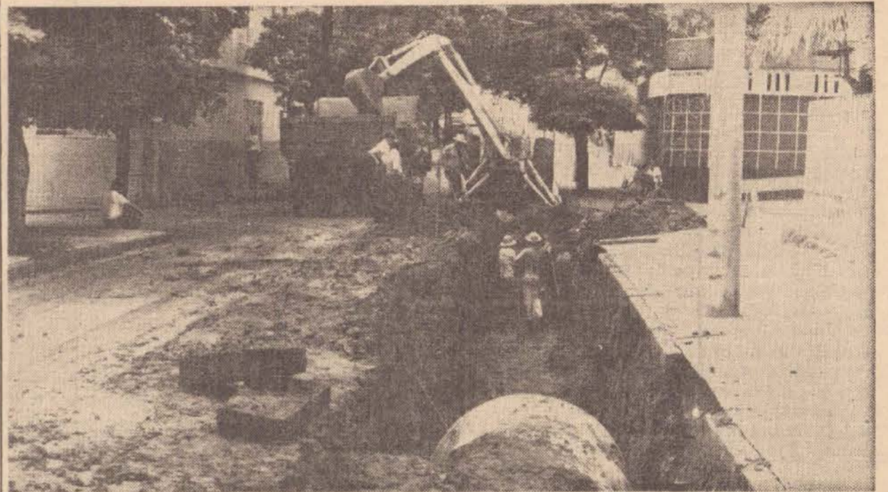
Aspecto das obras na rua Pedro de Oliveira Costa.
