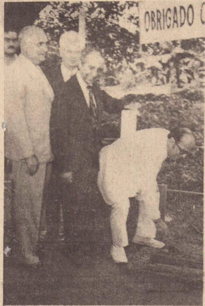
Momento em que o Dr. Julio Nunes de Abreu cimentava a pedra fundamental.
