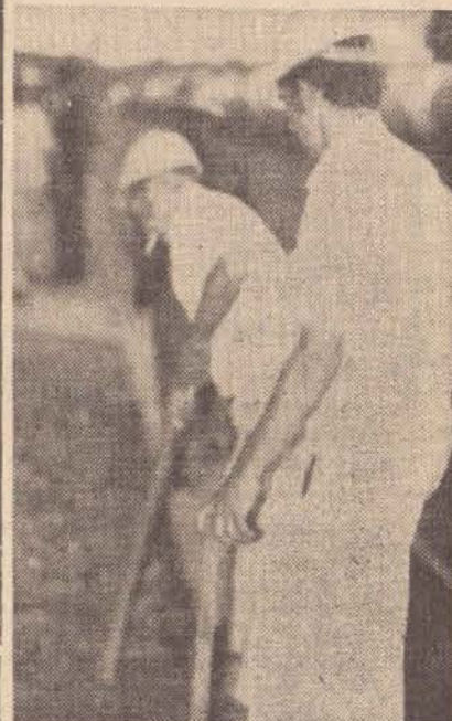
Utilizando picaretas e pás, todo o piso da estação de embarque estava sendo removido
