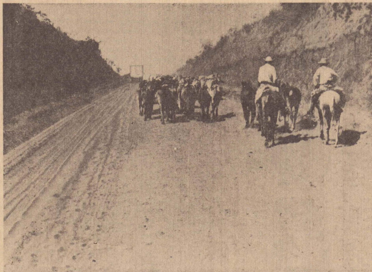
Gado na pista é cena comum da rodovia da Integração. Esse quadro começa a mudar com a chegada das máquinas e dos trabalhadores, que vão pavimentar a estrada.
