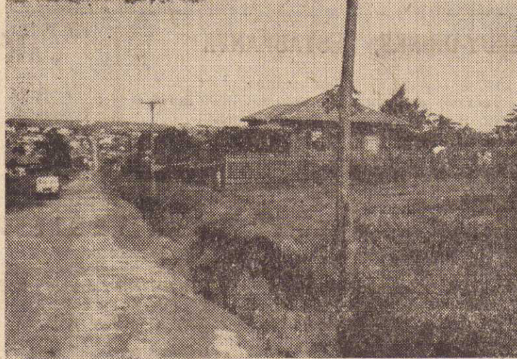
Devido a essa "vossoroça" as residências da direita, ficaram isoladas estando seus moradores sem saída para a rua. Barragens de madeira poderiam remediar o problema. — (FOTO 2)
