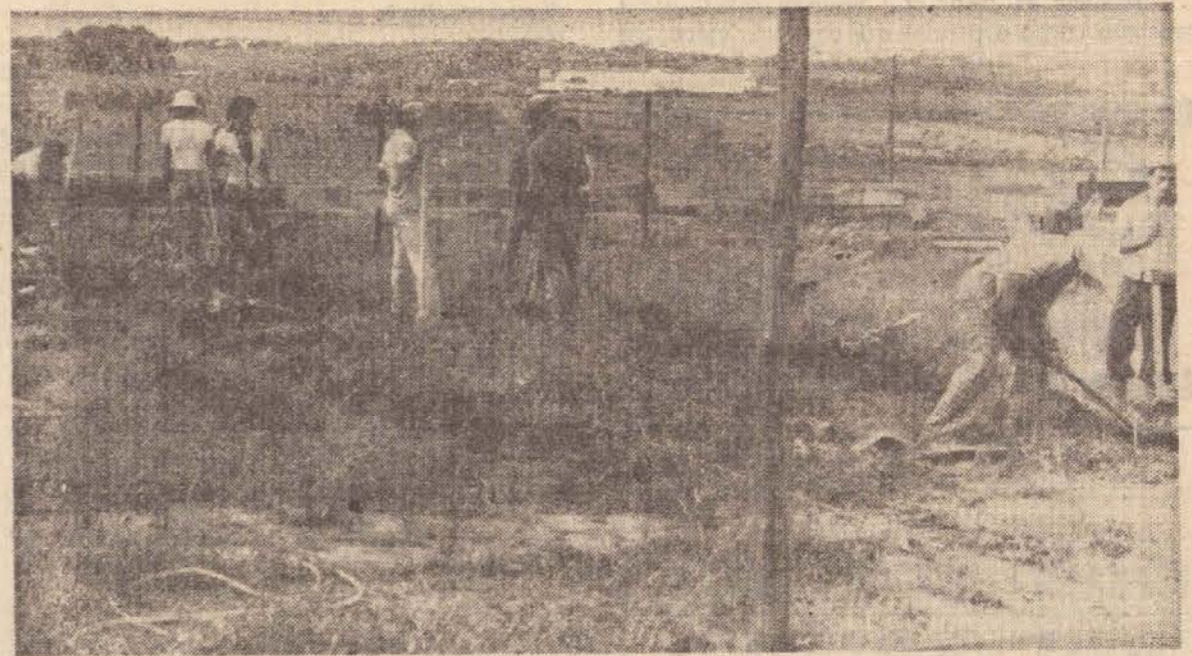
Depois de receber a infra-estrutura necessária, começa aqui a construção de 1.017 casas populares.
