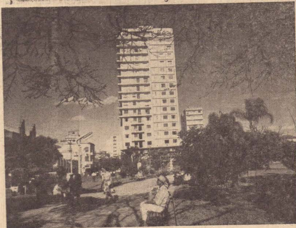
Eis uma vista do fabuloso Edifício Rosa Peretti, construído pela tradicional família Peretti de nossa cidade.
