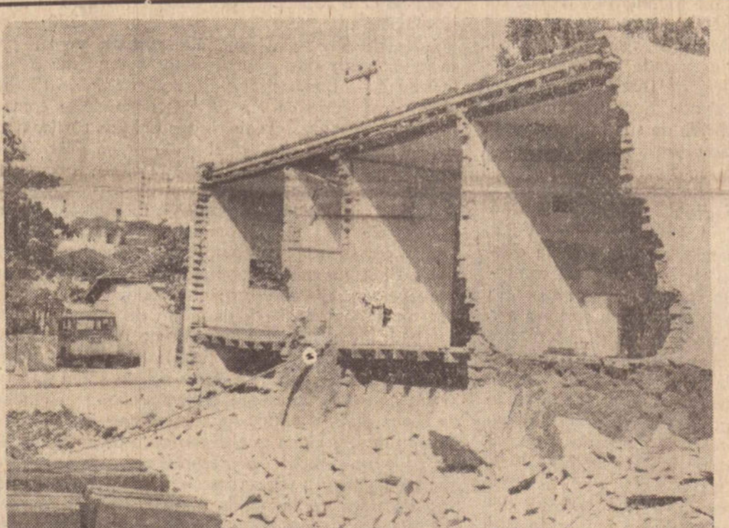
A extensão da rede de esgotos, fez a residência desmoronar.
